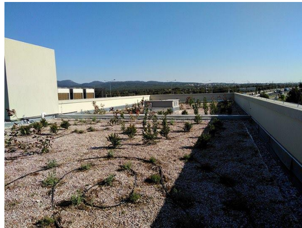
Κατασκευή πράσινου δώματος των κτηρίων διοίκησης Νέας Οδού-Βαρυμπόμπη (TERNA AE)
