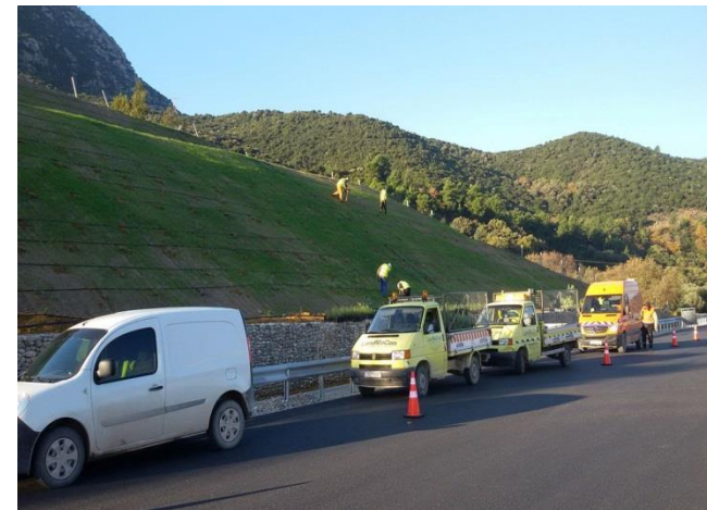
Φύτευση και εγκατάσταση τριτεύοντος δικτύου άρδευσης στη Ιονία Οδό Τμήματα S1 A & B & C (ΧΘ 0+000 – 43+502) / (ΤΕΡΝΑ ΑΕ)
