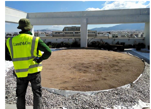
Εγκατάσταση και κατασκευή πράσινου δώματος των κτηρίων Εθνικής Τράπεζας
