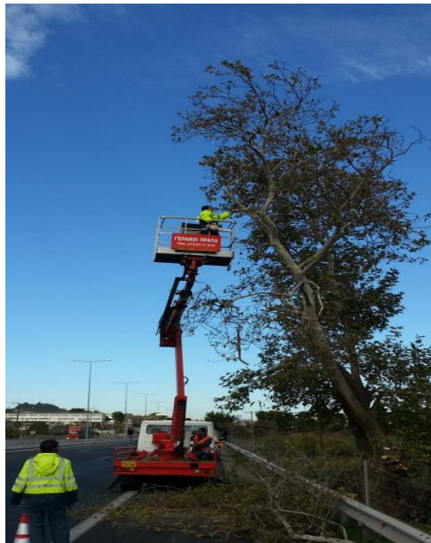
Συντήρηση πρασίνου αυτοκινητοδρόμου ΠΑΘΕ (ΑΚ Μεταμόρφωσης-Α/Κ Σκάρφειας - Νέα Οδός - ΓΕΚ SERVICES).
