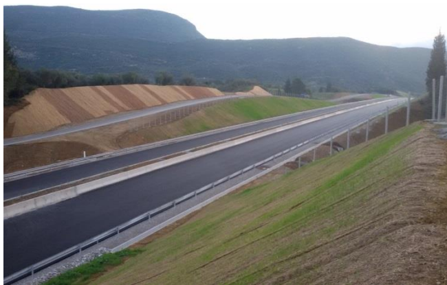
Φύτευση και εγκατάσταση τριτεύοντος δικτύου άρδευσης στη Ιονία Οδό Τμήματα S1 A & B & C (ΧΘ 0+000 – 43+502) / (ΤΕΡΝΑ ΑΕ)
