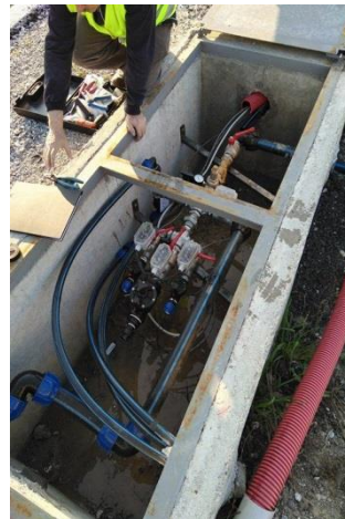
Εγκατάσταση αρδευτικών συστημάτων και αυτοματισμού στον Βόρειο Κόμβο Κατερίνης (J & P AVAX)
