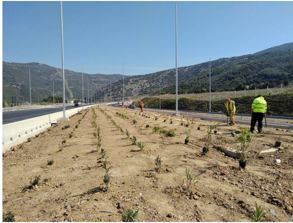
Φύτευση και εγκατάσταση τριτεύοντος δικτύου άρδευσης στη Κεντρική Νησίδα και τα πρανή του Τμήματος GU12 του Αυτοκινητόδρομου Αιγαίων- Τέμπη. (J & P AVAX)
