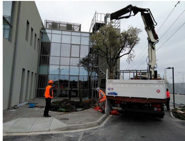
Μελέτη ,φύτευση και εγκατάσταση τριτεύοντος δικτύου άρδευσης στον περιβάλλοντα χώρο των γραφείων διοίκησης Νέας Οδού- Βαρυμπόμπη (TERNAE)
