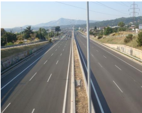
Φύτευση και εγκατάσταση τριτεύοντος δικτύου άρδευσης στη Κεντρική Νησίδα του Αυτοκινητόδρομου Π.Α.ΘΕ. ( ΤΕΡΝΑ – ΓΕΚ SERVICES )
