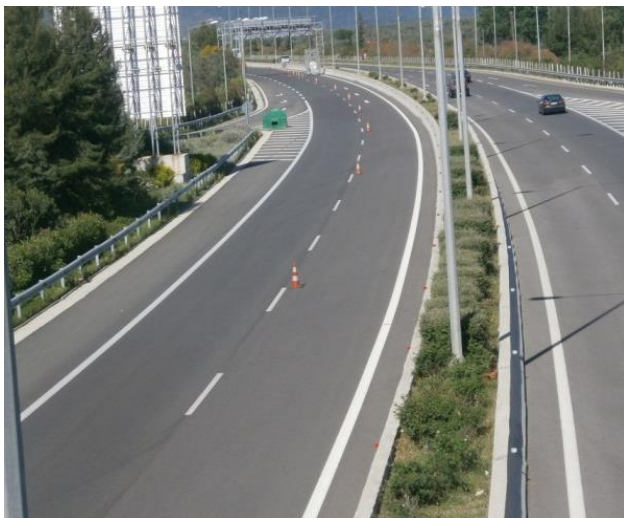
Συντήρηση πρασίνου αυτοκινητοδρόμου ΠΑΘΕ (ΑΚ Μεταμόρφωσης-Α/Κ Σκάρφειας - Νέα Οδός - ΓΕΚ SERVICES).
